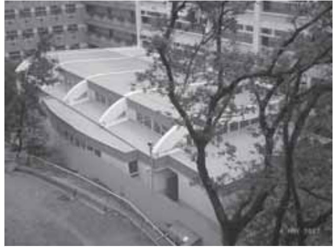
泳池上蓋工程竣工
