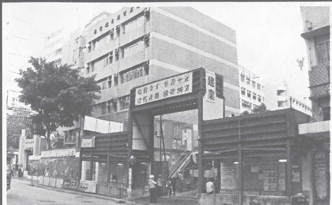
■培正新教學大樓的建築工程由建業建築投得,料於2011年落成啟用。圖為大樓建築地盤。司徒世華攝
