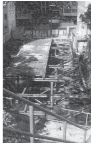
在山坡上看見培正教育大樓地地基已完成
